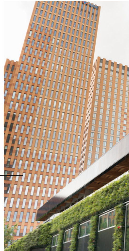
Foto 1: Het paviljoen Circl van ABN Amro op de Zuidas is circulair gebouwd: niet alleen is er gebruikgemaakt van eerder gebruikte materialen, ook is het demontabel gebouwd.
