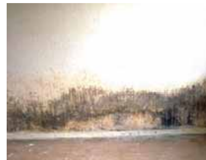
Meting is niet altijd nodig om problemen te herkennen: schimmel op een zijgevel.
