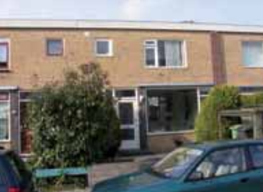
Woning met houten platdakconstructie behoort tot de groep van risico-objecten.
