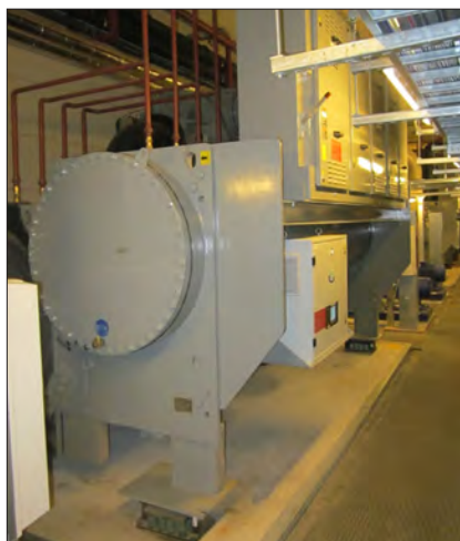
-Figuur 5- opstelling van een KM; één van de trillingsisolatoren is zichtbaar
