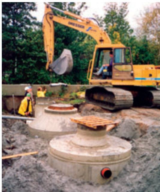
Aanleg zuiveringsvoorziening voor hemelwater.
