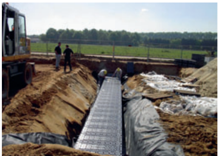
Aanleg infiltratiekratten.
