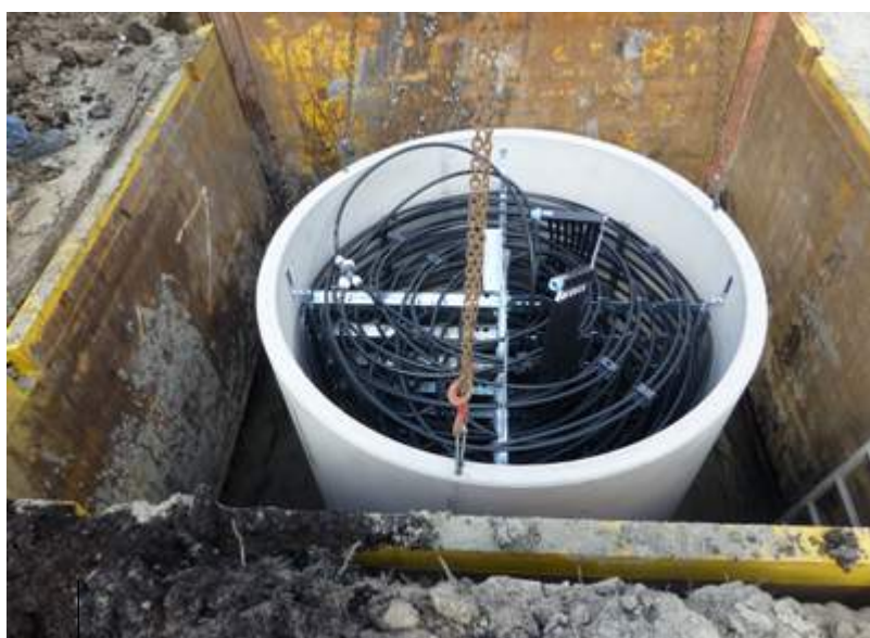
Figuur 4: Een kleine ijsbuffer voor grondgebonden woningen, gebruikt bij Het IJs van Columbus.
